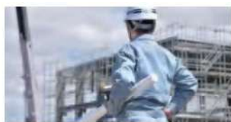
建設・工事現場
