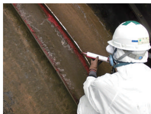
エキスパンジョイントの漏れ防止 流体 150℃のガスの施行中
