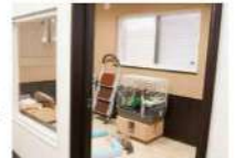
▲壁面は幅木を立ち上げて汚れをとりやすくした。隣室からも様子が見えるよう、飛び越えられない高さの内窓を設置▲
