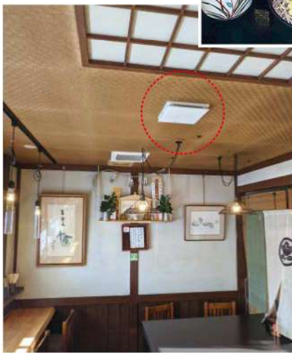
1階の店内に循環ファン2台を設置
