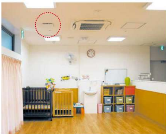
約57㎡の保育ルームに循環ファンが2台設置された。これは窓側の1台▶
