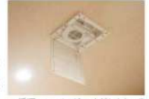
▲循環ファンのパネルを外したところ
