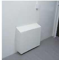
●吸い込み口フード（室内）
