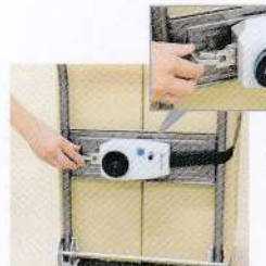
ベルト先端のフックを横締め専用プレートの穴に引っ掛ける。
